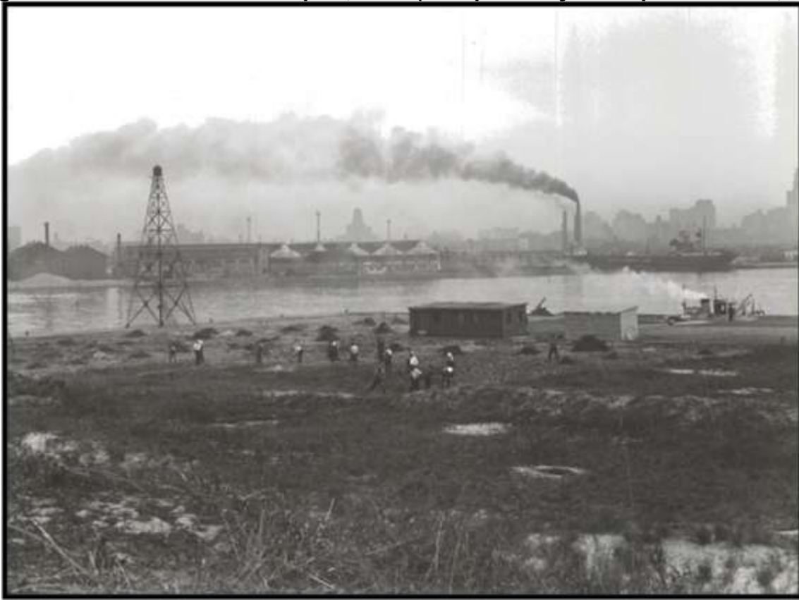
Image 1 : Construction de l'aéroport, 1937 (Aéroport Billy Bishop de Toronto, 2024)
