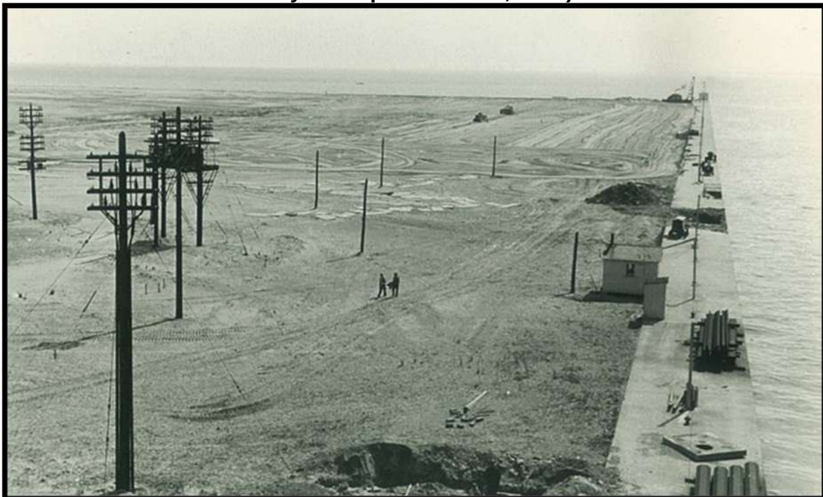
Image 2 : Construction de l'aéroport avec murs de soutènement, 1937 (Aéroport Billy Bishop de Toronto, 2024)
