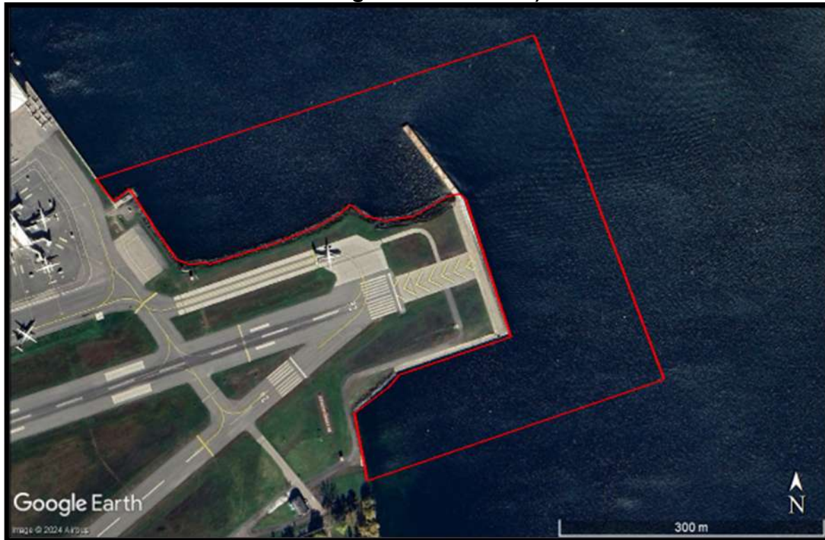
Figure 3 : Conditions actuelles de la zone d'étude est (Google Earth, date d'imagerie : 11/06/2022)
